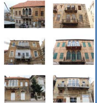
Fig. 17. Maison à 2/3 arcades
