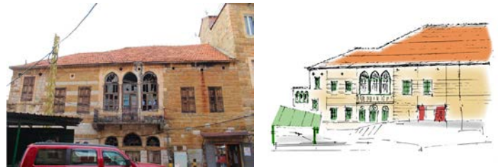
Fig. 70. Bâtiment à côté de la mairie
