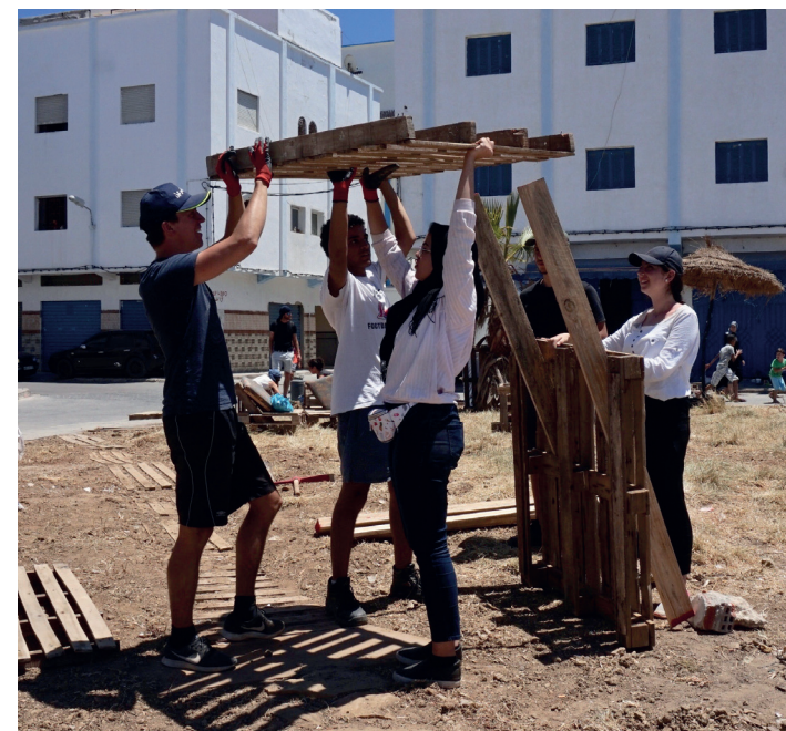
Construction de l'arche centrale
