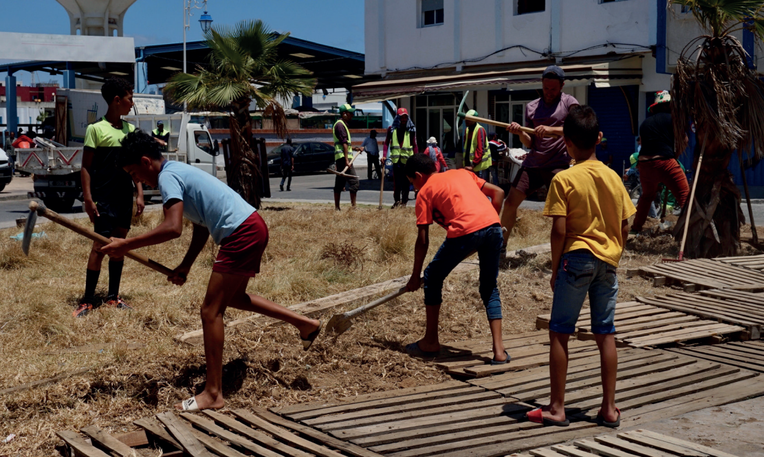
Installation de la terrasse en palettes Les enfants se sont beaucoup impliqués dans le chantier.
