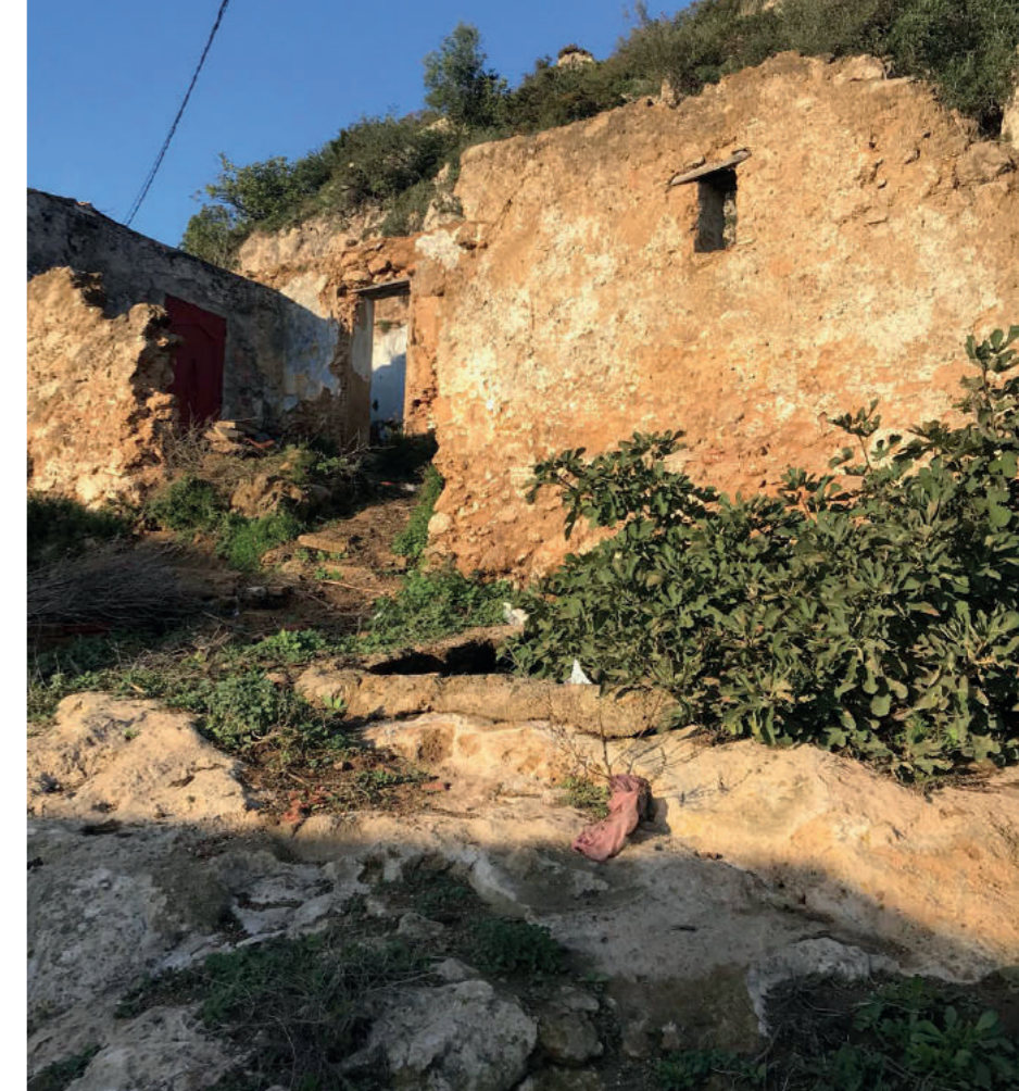
Image 12 : Un vestige de construction traditionnelle
