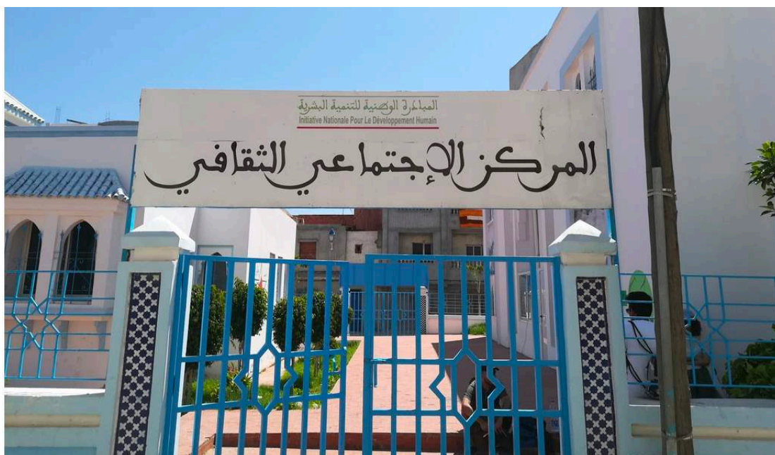
Fig. 10. La maison de quartier de Diza. Crédit photo: Louis Lesty
